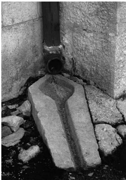
Fig. 11. Pierre à gouttière, déversoir de chéneau (église de La Mouille).
