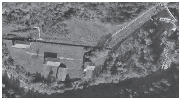
Vue aérienne actuelle des bâtiments. Celui le plus à gauche est l'usine électrique. Le pont et le barrage sont en haut à droite.
