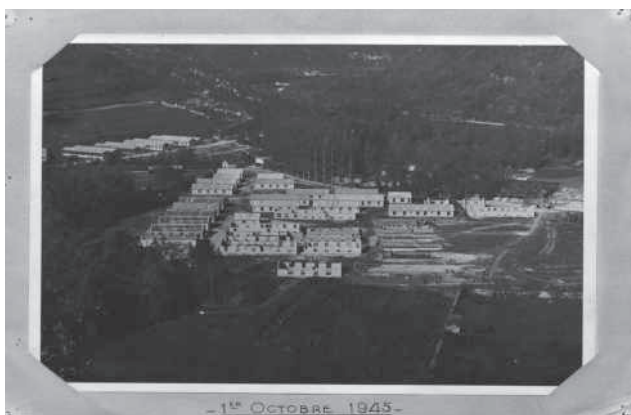
La cité en cours de construction au 1.10.1945. AD de l'Ain 61W261.
