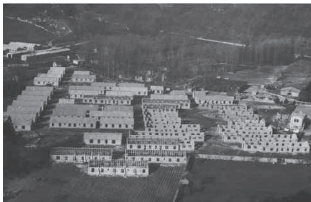
La cité en cours de construction, s.d.. AD de l'Ain 61W261.
